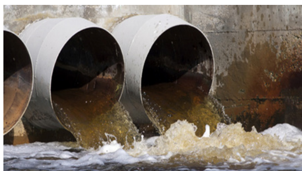
Figura 83: Boa parte dos problemas relacionados à água em ambiente urbano são oriundos da disposição inadequada de esgotos domésticos e industriais em cursos d'água. Foto:©Reddogs/ Fotolia.
