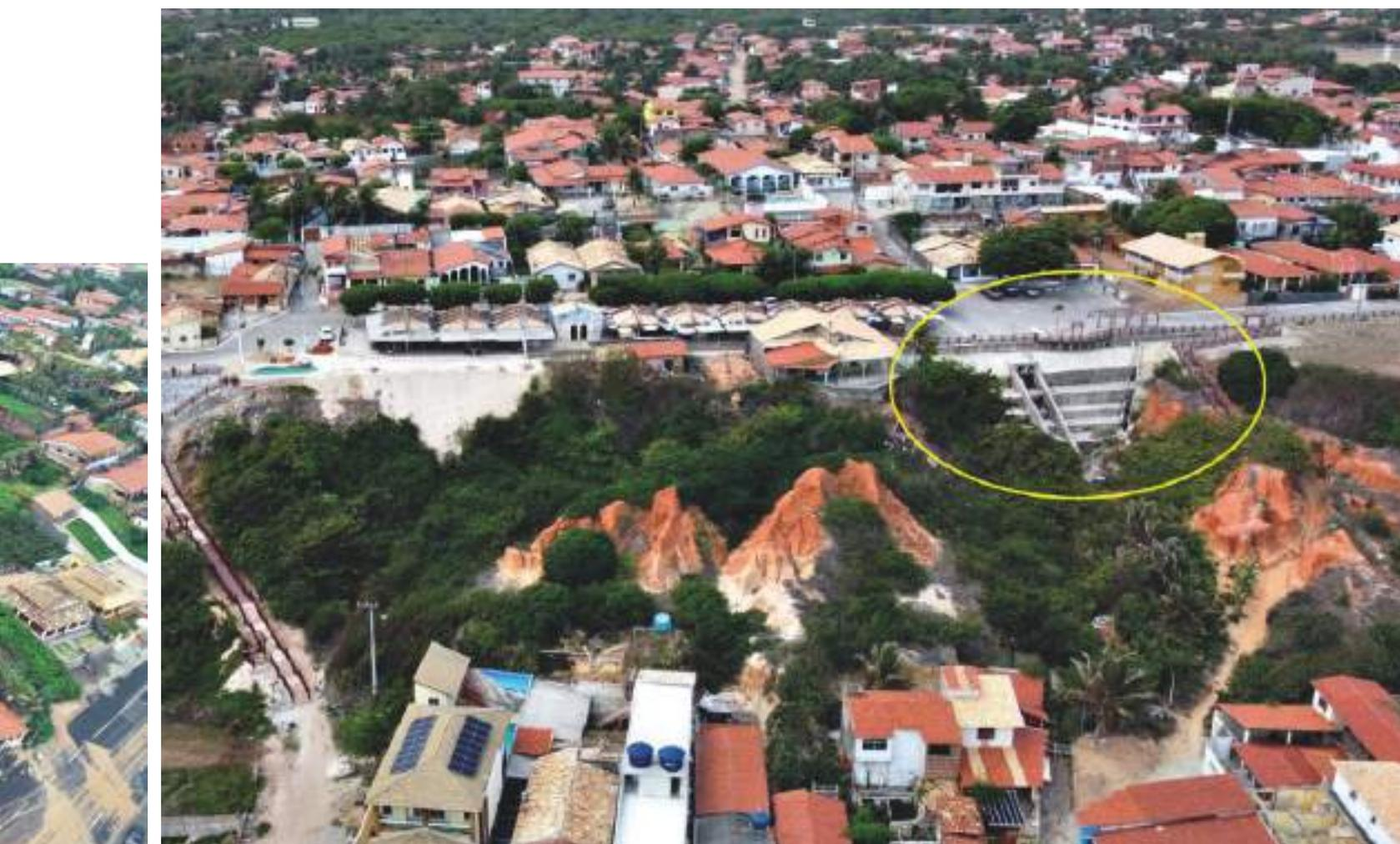
Figura 41 - Obra de contenção (círculo amarelo) com taludes escalonados de concreto na praia de Morro Branco, após o fluxo de detritos que destruiu parte da infraestrutura urbana do setor em 2021
