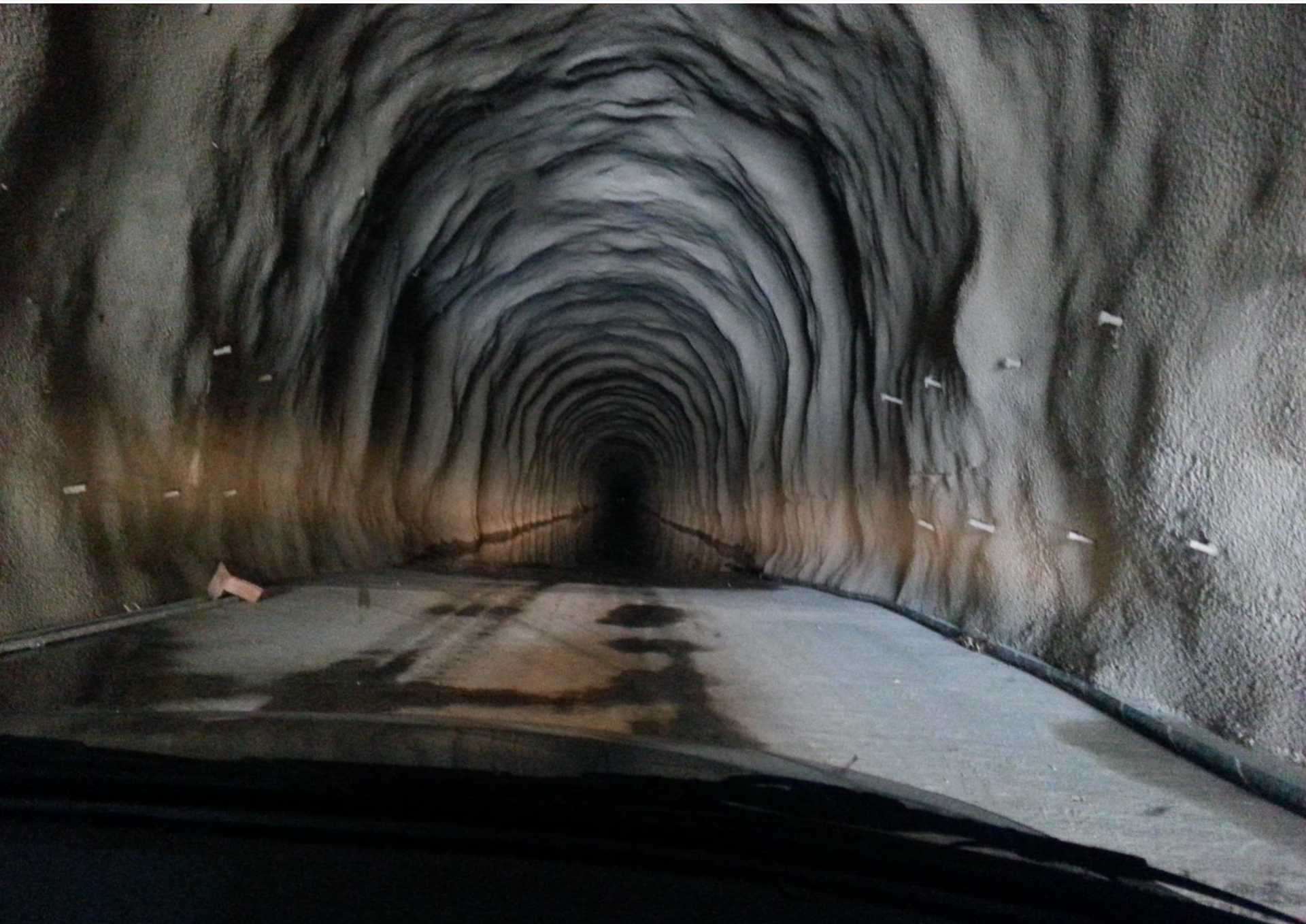
Túnel Cuncas II (4KM)
