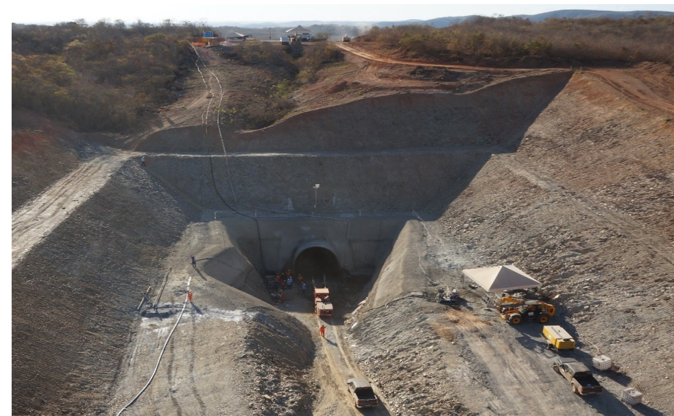
TÚNEL CARNAÚBA – Emboque
