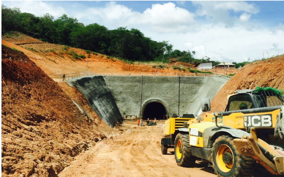
TÚNEL SÍTIO ALTO 1 – Emboque
