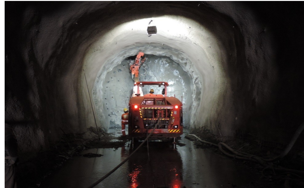
TÚNEL CRUZEIRO - Desemboque
