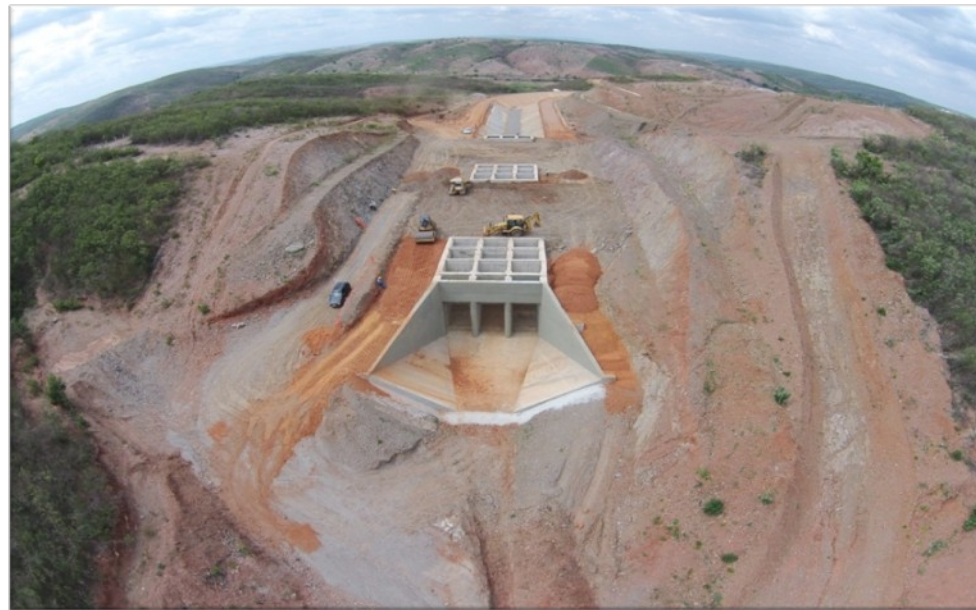
Vista da captação no Lago da Barragem Jati
