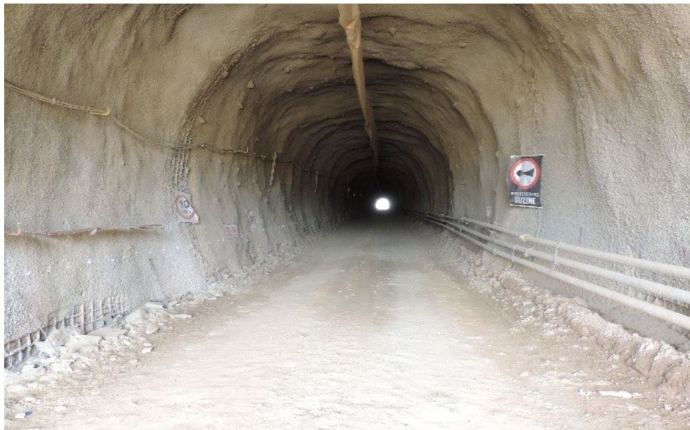
TÚNEL PAI MANÉ - Desemboque
