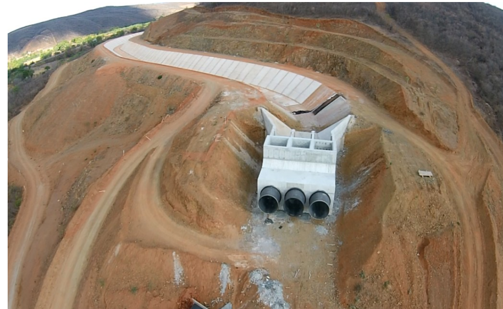
Vista do Sifão Beleza
