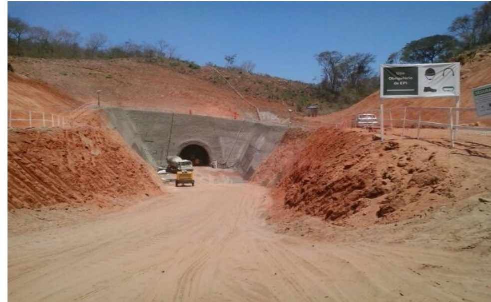
TÚNEL SÍTIO ALTO 1 – Desemboque
