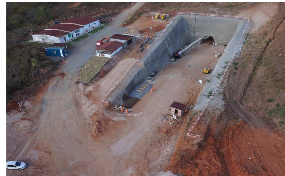
TÚNEL VENEZA – Desemboque
