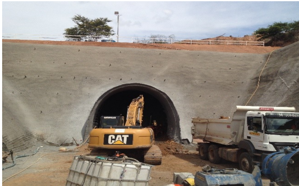
TÚNEL BOA VISTA – Desemboque
