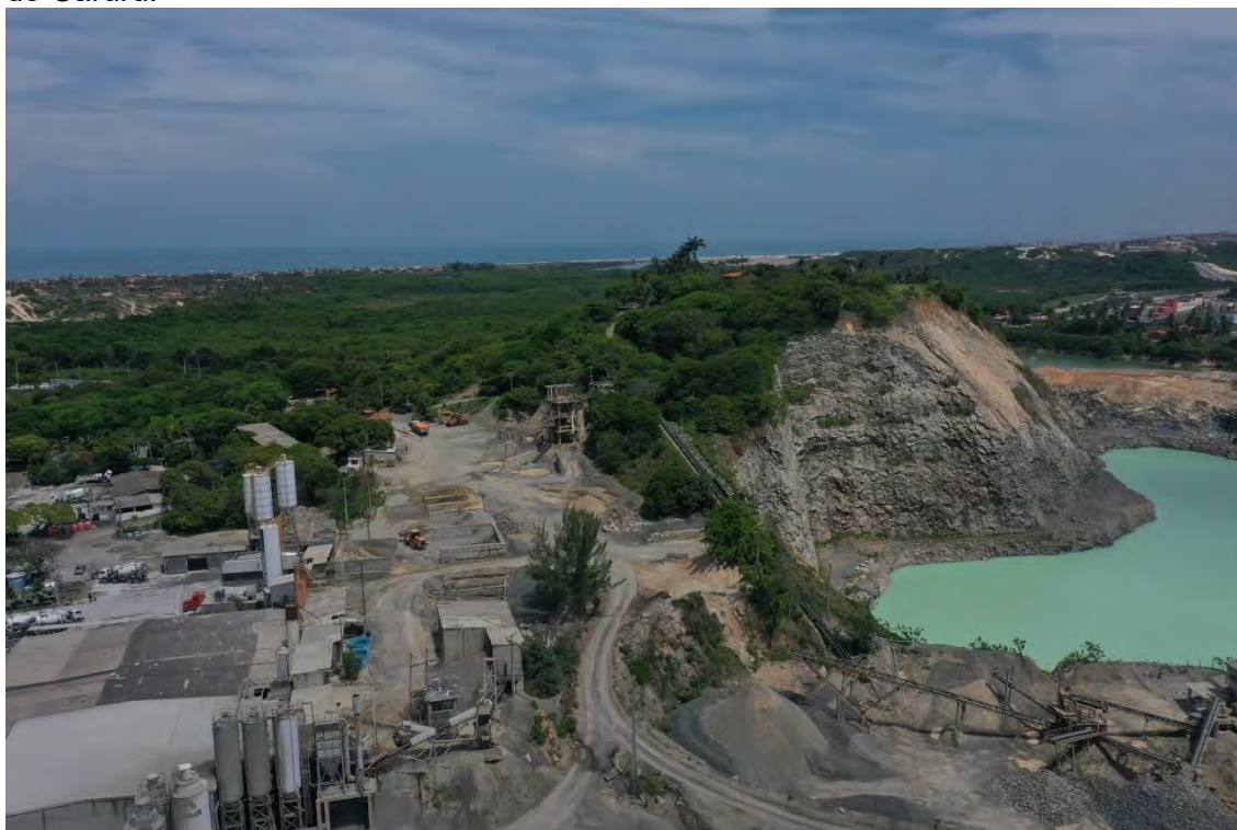
Figura 53 – Cava de mineração e ocupação industrial na vertente ocidental do Neck Vulcânico do Caruru.
