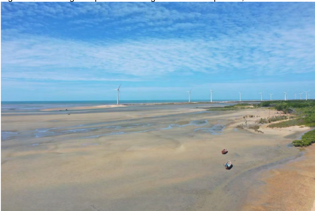
Figura 20 – Restinga ocupada com aerogeradores em espreado, Acaraú.
