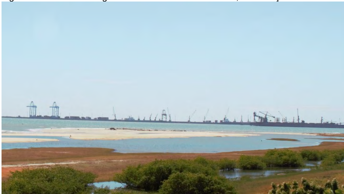
Figura 97 – Pier de atracagem de navios no Porto do Pecém, São Gonçalo do Amarante.
