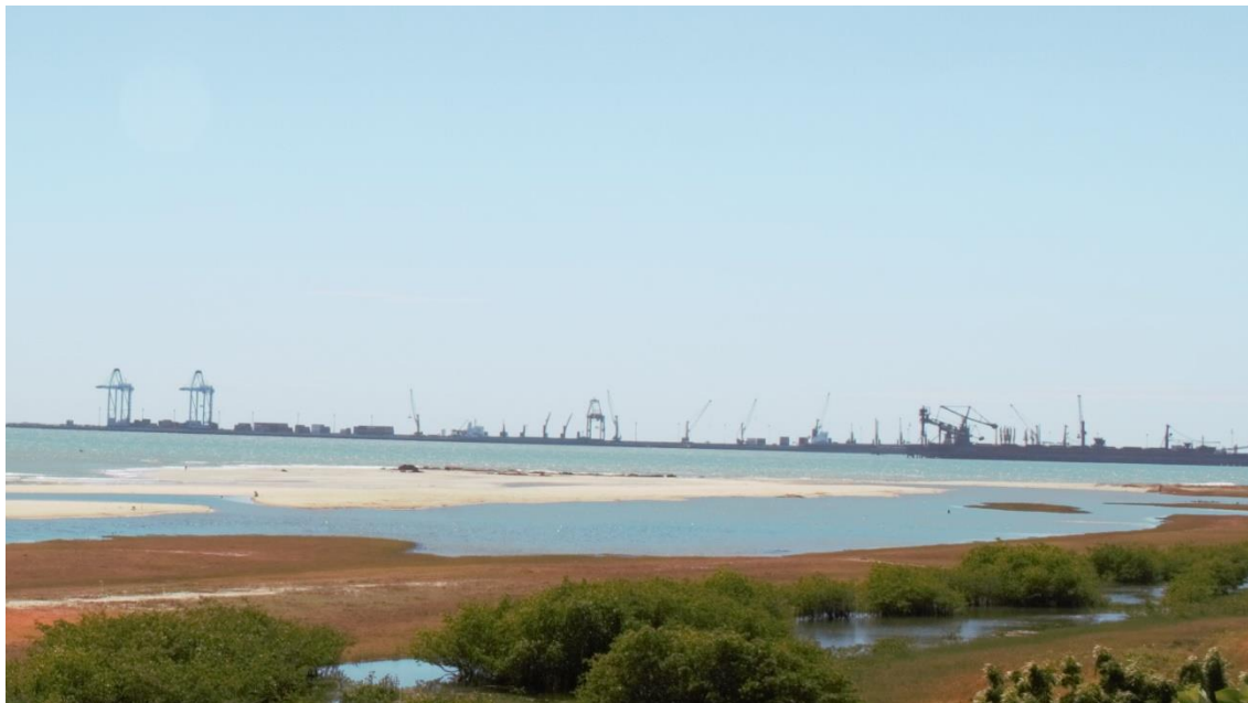
Figura 70 – Setor 2 Pier de atracagem de navios no Porto do Pecém, São Gonçalo de Amarante.
