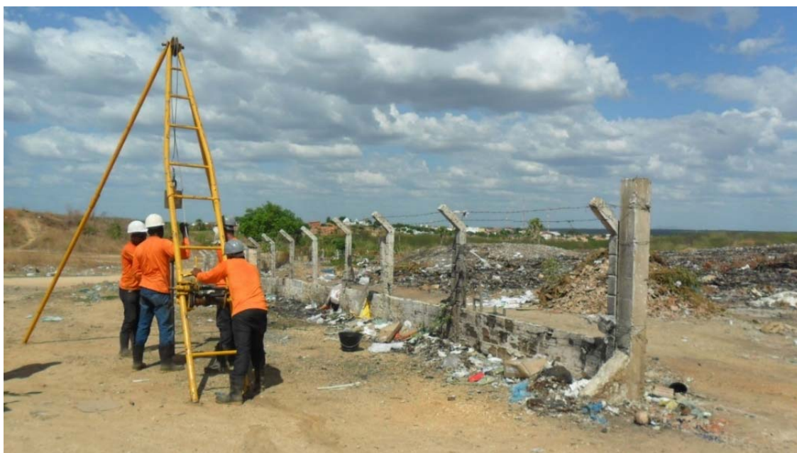
Figura 4.1 – Vista da direção sudoeste - Lixão de Reriutaba (sede). Fonte: TÜV SÜD Bureau.
