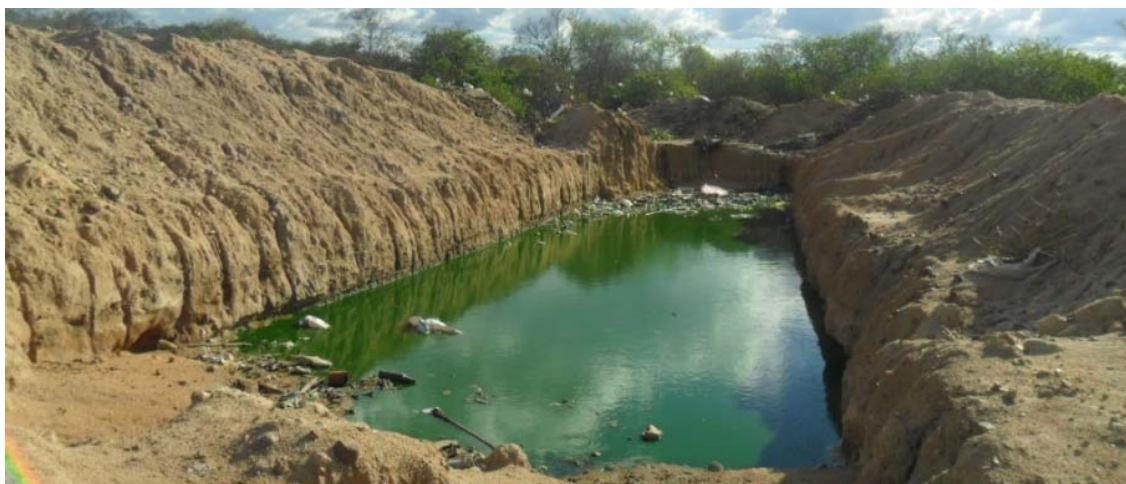
Figura 4.7 – Vala para recebimento de efluentes de fossas sépticas no Lixão de Groaíras. Fonte: TÜV SÜD Bureau.
